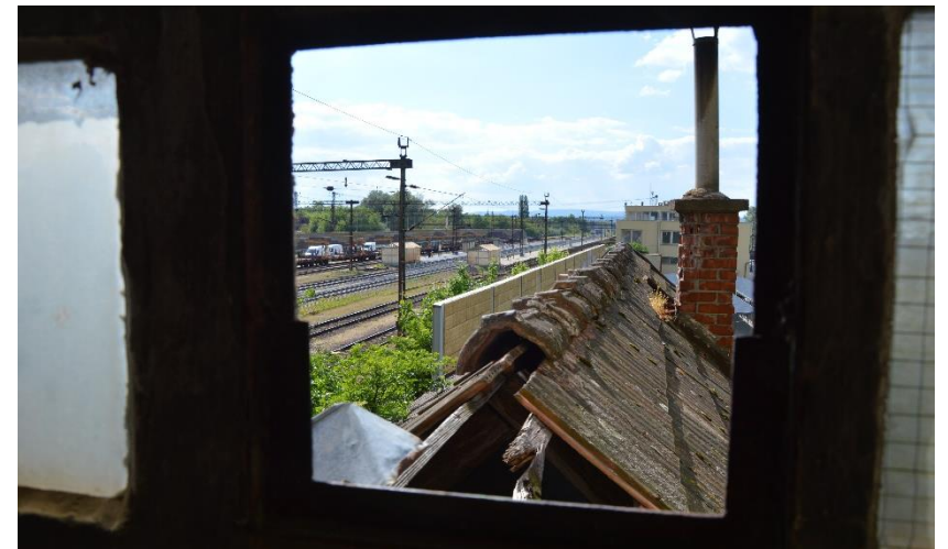
Kilátás a vasútra
