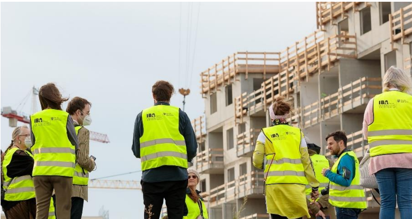
10. Fotó: Építkezés bejárás koncepció-pályázat módszerével fejlesztett területen, Bécs Forrás: IBA_Wien 2022 - https://www.facebook.com/ibawien2022/photos/1105548119908221
