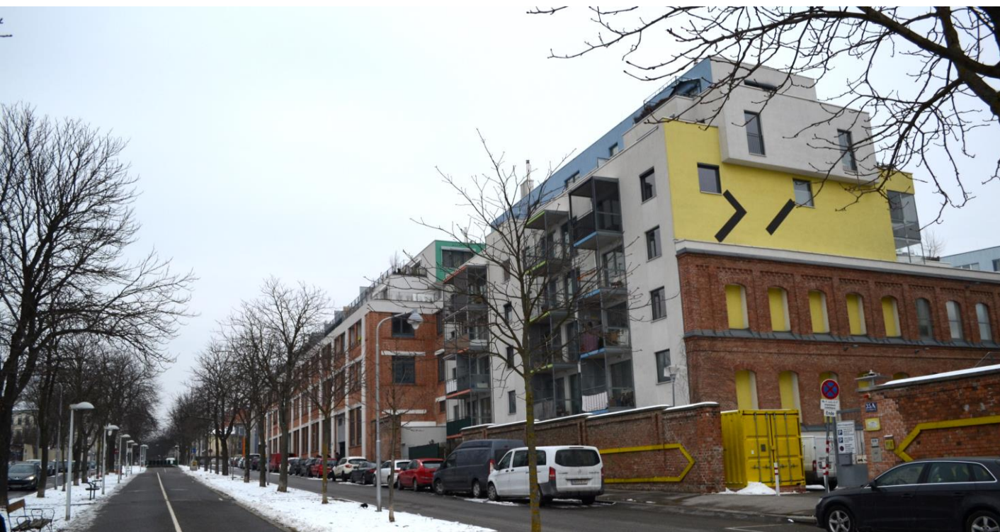
2. Fotó: Kabelwerk fejlesztési terület, előtérben a Kalypso Frauenwohnprojekt közösségi lakóház, Bécs
