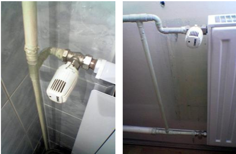
Egycsöves rendszer átalakítása, átfolyósra és termostatikus szeleppel történő ellátása
