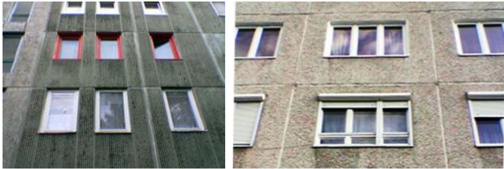
Különböző szerkezetű, színű cserélt nyílászárók
