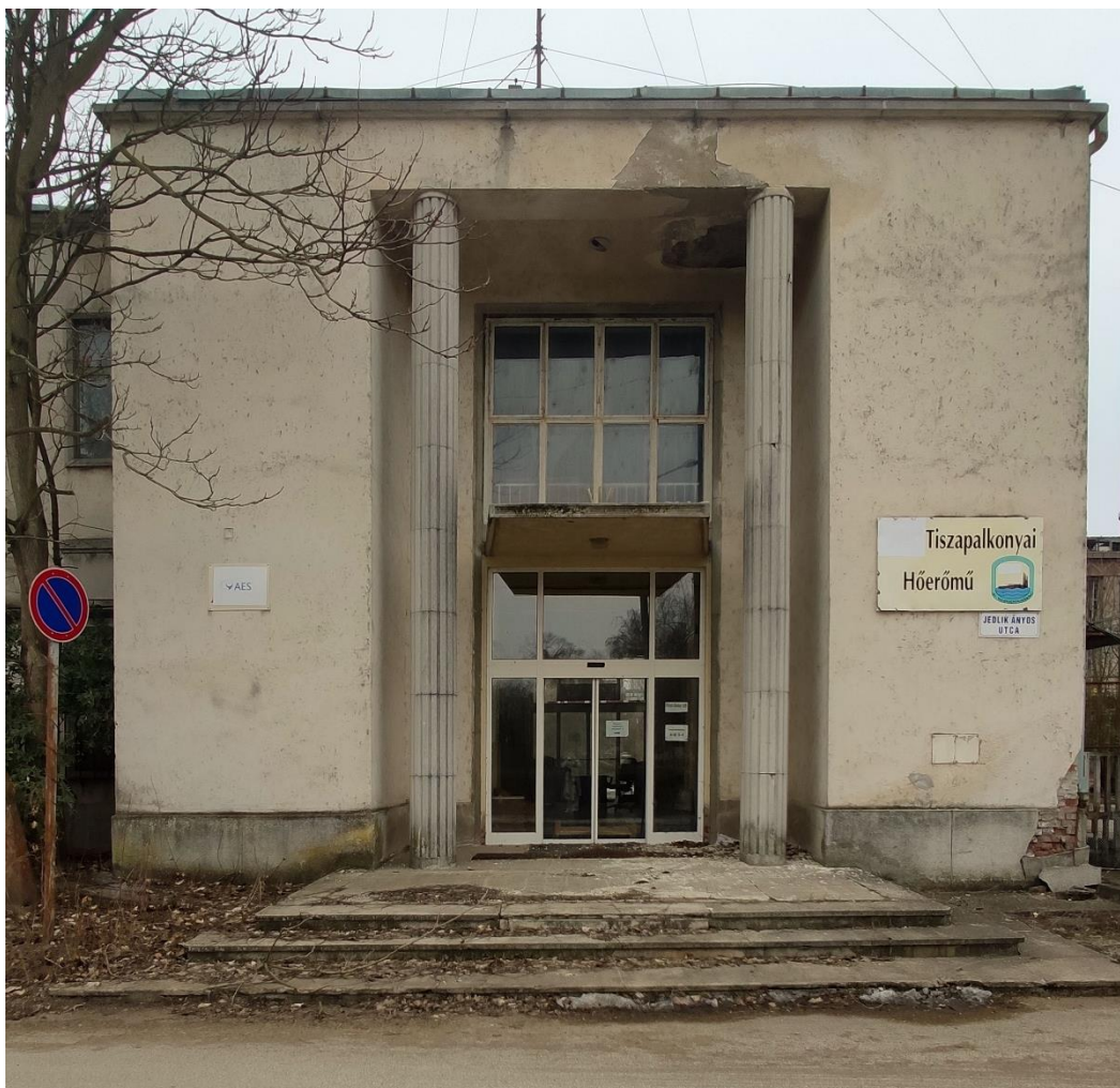
(41) Északkelti homlokzati bejárata.
