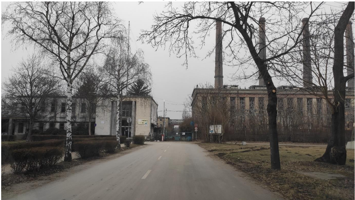
(40) hőerőmű fogadóépülete és a turbinacsarnoka.
