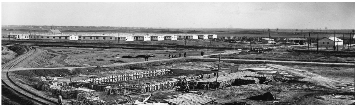
(17) Az előtérben folyik a vasút pályájának építése, a háttérben a munkások barakkjai láthatóak.
