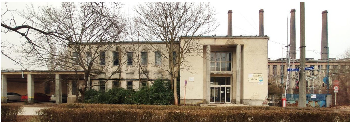
(1) A fogadóépület jelenlegi állapota. (saját felvétel)
