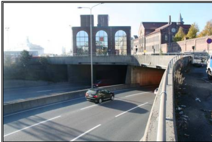
17. A városközpont alatt épített alagút bejárata (fotó: Tosics Iván)
