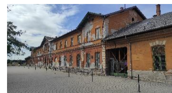
4. kép: Állomás épülete
