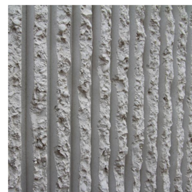
Homlokzat beton burkolat
